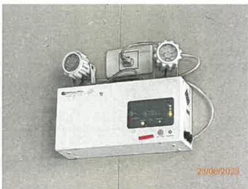
รูปที่ 46 ระบบไฟฟ้าส่องสว่างฉุกเฉิน
