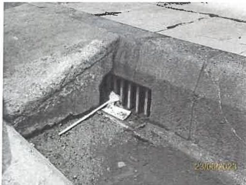
รูปที่ 39 ท่อรวบรวมน้ำจากการล้างห้องพักมูลฝอย เข้าสู่ระบบบำบัดอาคาร A
