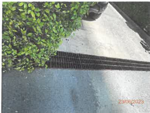
รูปที่ 59 ตะแกรงครอบท่อระบายน้ำ
